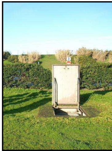
Acceso a pozos
