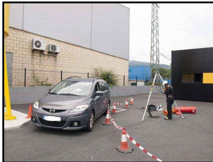
Control y desvío del tráfico rodado junto a un recinto confinado
