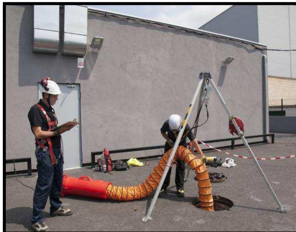
Instalación de un sistema de ventilación
