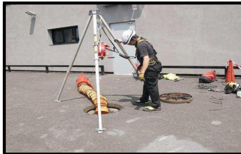
Vigilante en la boca del recinto confinado
