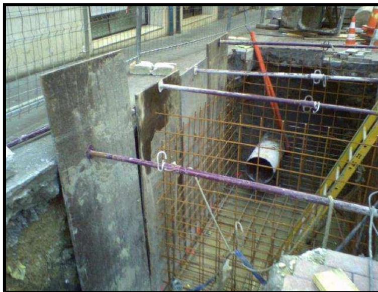
Entibación con planchas de metal
