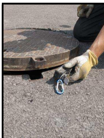
Semiapertura de un recinto confinado
